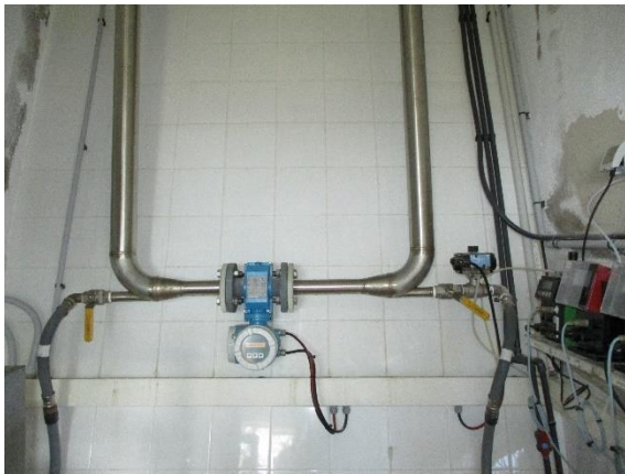
Il·lustració 27. ETAP Dipòsit Nou: mesuradors en línia i bombes dosificadores
