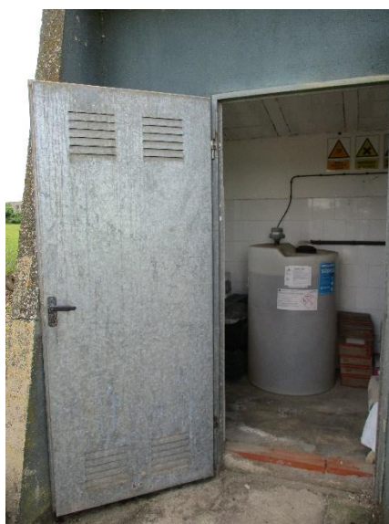
Il·lustració 18. Sobreelevació Ter: emmagatzematge i dosificació d'hipoclorit sòdic
