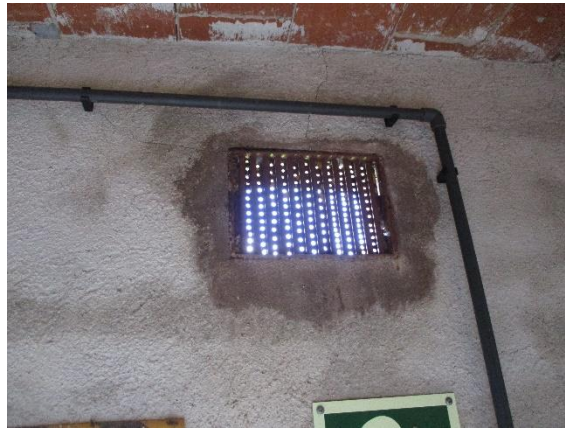
Il·lustració 32. Dipòsit Vell: sala d'emmagatzematge i dosificació d'hipoclorit sòdic
